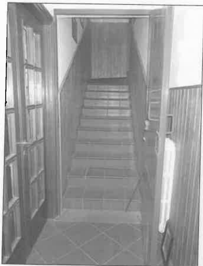
FOTO 58 - VANO SCALA PS1-PT
