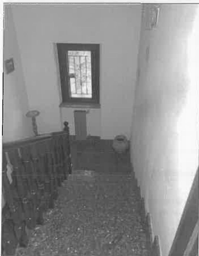
FOTO 33 - VANO SCALA PT-P1
