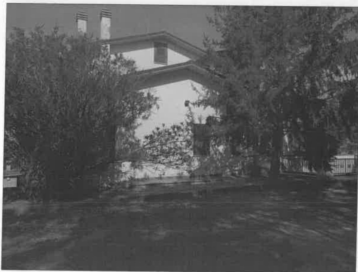
FOTO 20 - PROSPETTO LATERALE EST
