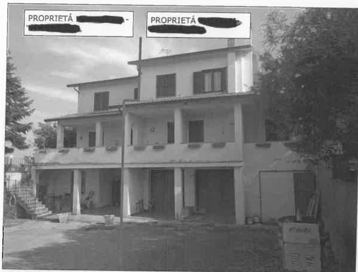
FOTO 21 - PROSPETTO SUD VILLA BIFAMILIARE
